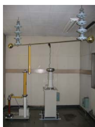
耐電圧試験機
